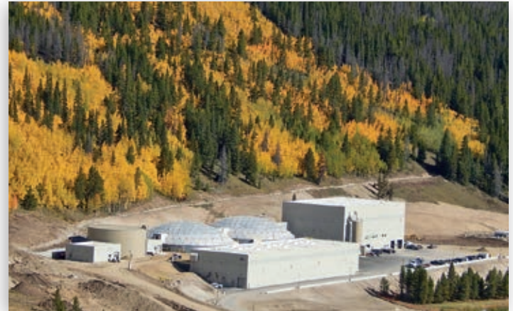
En julio de 2014, la planta de tratamiento de aguas de Climax Molybdenum, que cuenta con tecnología de punta, inició sus operaciones para tratar hasta 14.000 galones por minutos de agua proveniente de las Instalaciones de Almacenamiento de Relaves Mayflower. El agua tratada es vertida en el Arroyo Ten Mile, donde existen pesquerías locales y áreas recreativas en el Condado de Summit, Colorado, Estados Unidos.
