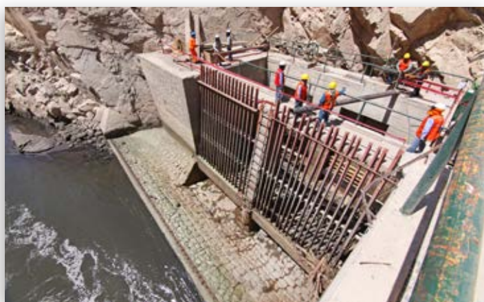
Como parte de la labor de Cerro Verde para mejorar la infraestructura hídrica dentro de la región de Arequipa, en 2014 finalizó la reconstrucción de compuertas en el Río Chili. Las nuevas compuertas reemplazan la infraestructura antigua y ayudan a mantener la integridad de los sistemas de riego agrícola de la región durante eventos de precipitación graves.
