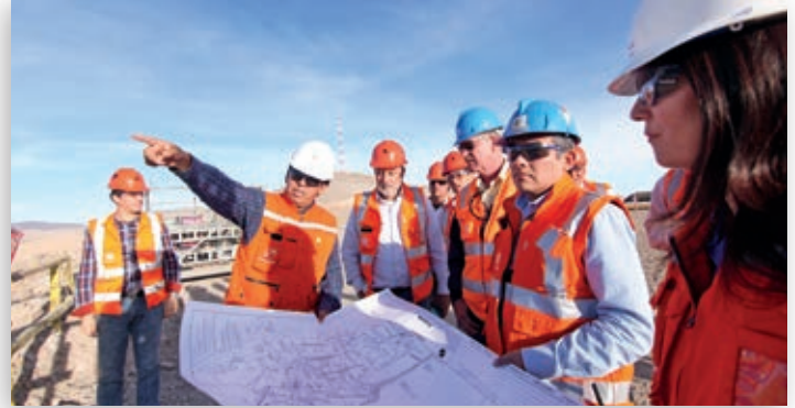
El ex Ministro de Energía y Minería del Perú, Eleodoro Mayorga (tercero desde la izquierda), y miembros de la gerencia de Cerro Verde, observan la construcción de una planta de tratamiento de aguas servidas que mejorará la calidad del agua en la región de Arequipa. La planta complementará el suministro de agua actual en apoyo a la expansión de la planta concentradora, para alcanzar las 360.000 toneladas métricas de mineral al día.
