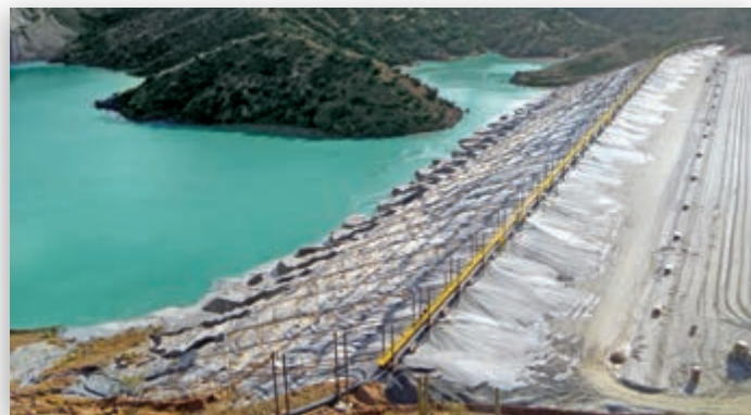
El dique de relaves Upper Mammoth en Bagdad, Arizona, es una expansión del dique original construido en 1985. El dique, construido con el método "centerline" permitirá hasta 18 años de almacenamiento de relaves antes de alcanzar su capacidad máxima.
